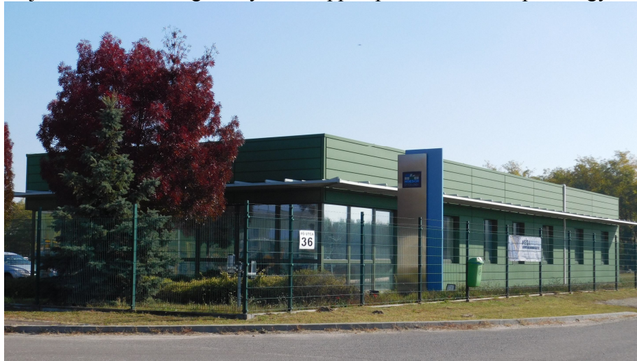
A szendvicspanel gyár irodaépülete korszerű, igényes épület.
